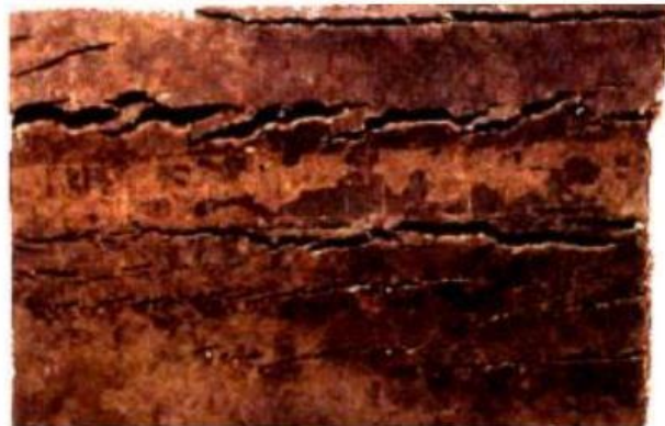
Figure I.8 : Fissures de CSC
