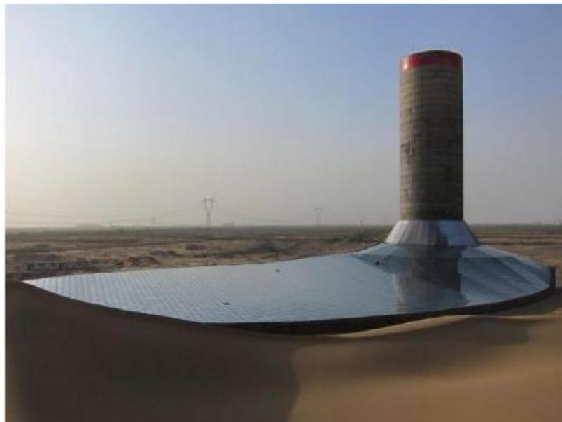
**Figure. II.15.** Photo de la centrale à cheminée solaire de JINSHAWAN, en Mongolie en Chines.
