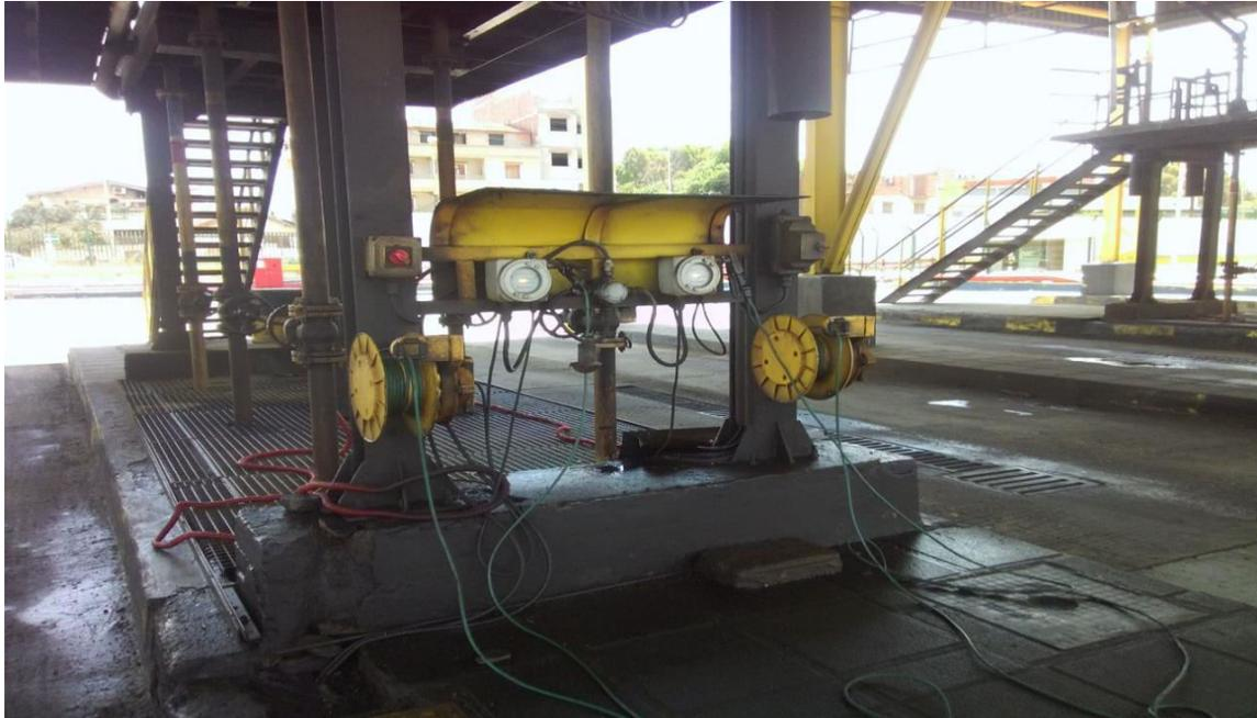
**Figure 24 : Dispositif contrôle de la mise à la terre**
