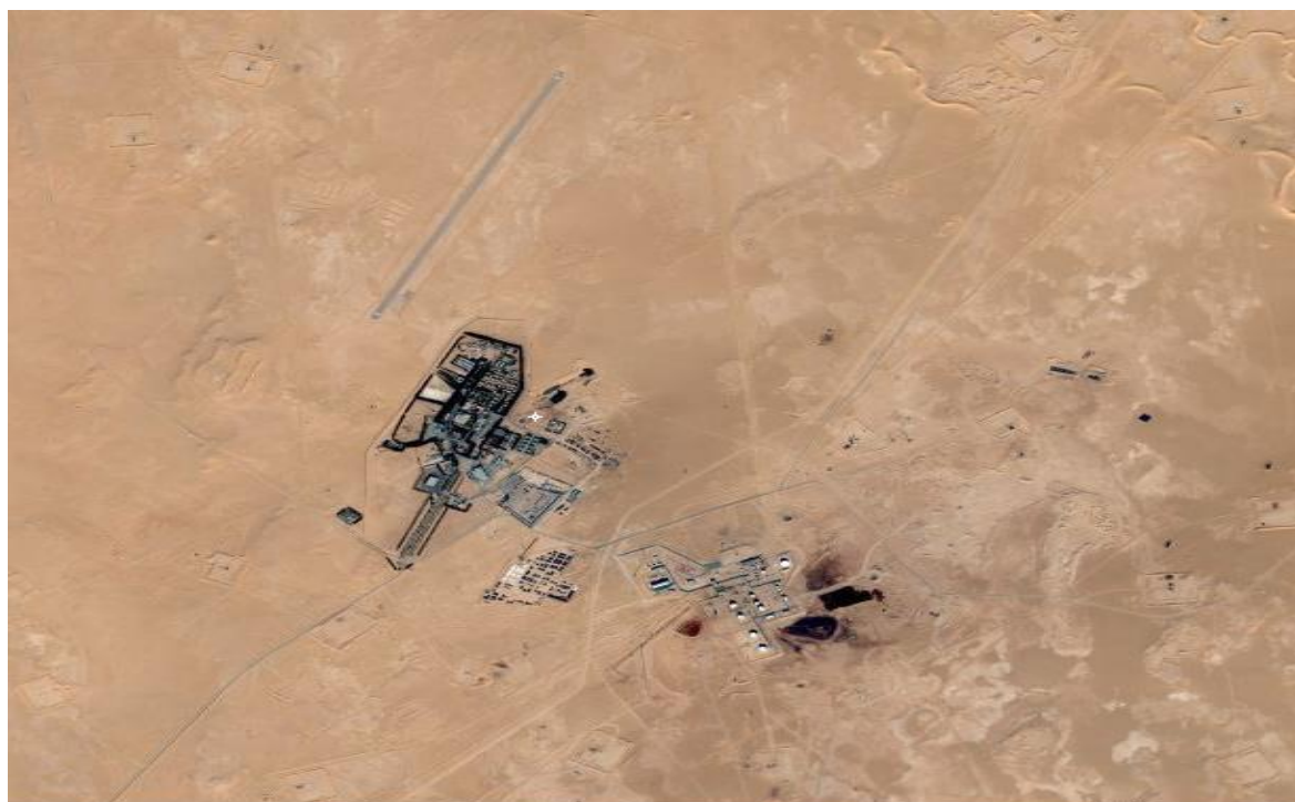
Figure 3 : Site principale (base de vie et centre GS-1) de SONATRACH
