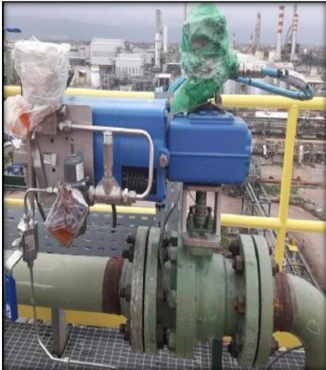
**Figure I.5 :** Vanne anti-feu de commande à distance.
