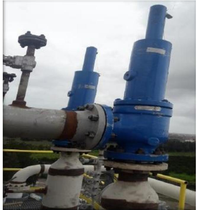
**Figure I.6.** Soupape de sureté
