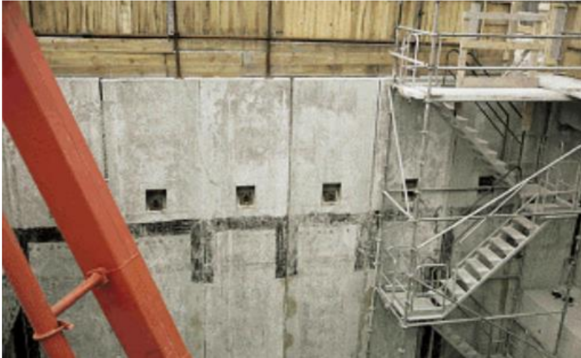
Figure 2.7 : Parois moulées ou préfabriquées.
