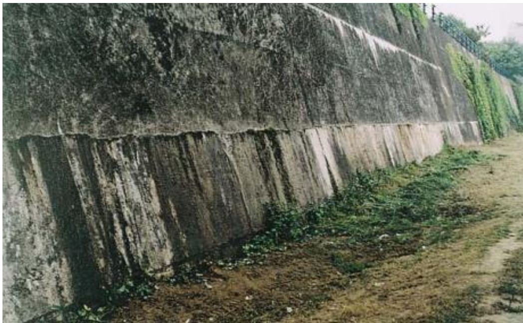
Figure 2.4 : Mur poids en béton.
