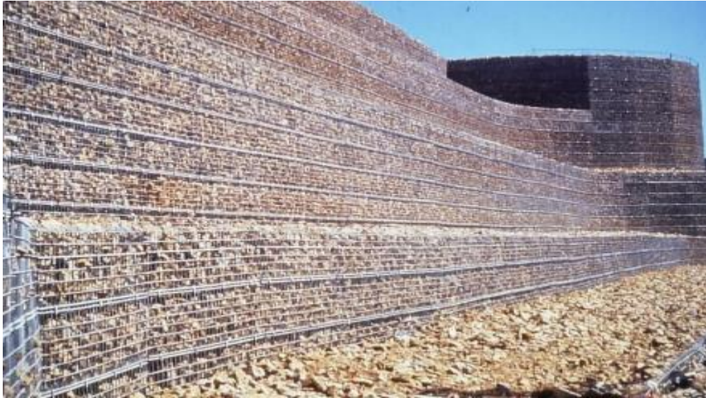
Figure 2.3 : Mur en gabions.
