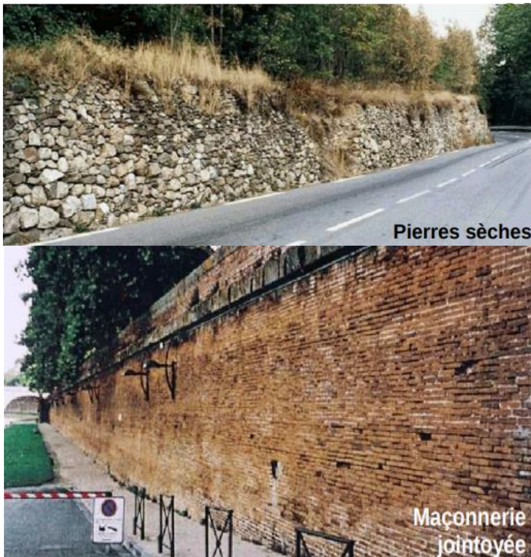
Figure 2.2 : Murs en maçonnerie et en pierres sèches
