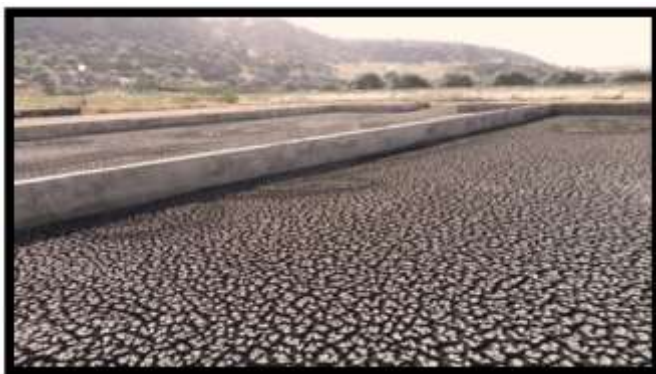
Figure III-11: le dépôt de stockage
