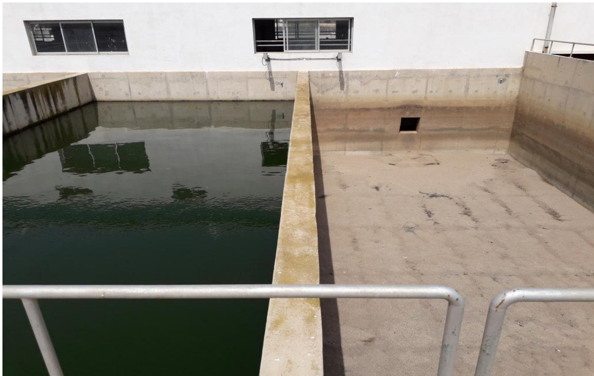
Figure III.8: filtre vide et plein
