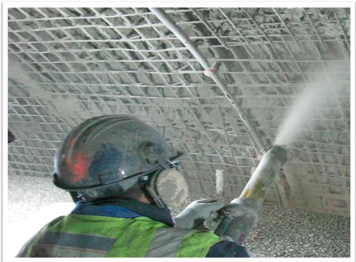
**Fig. I.8.** Béton projeté
