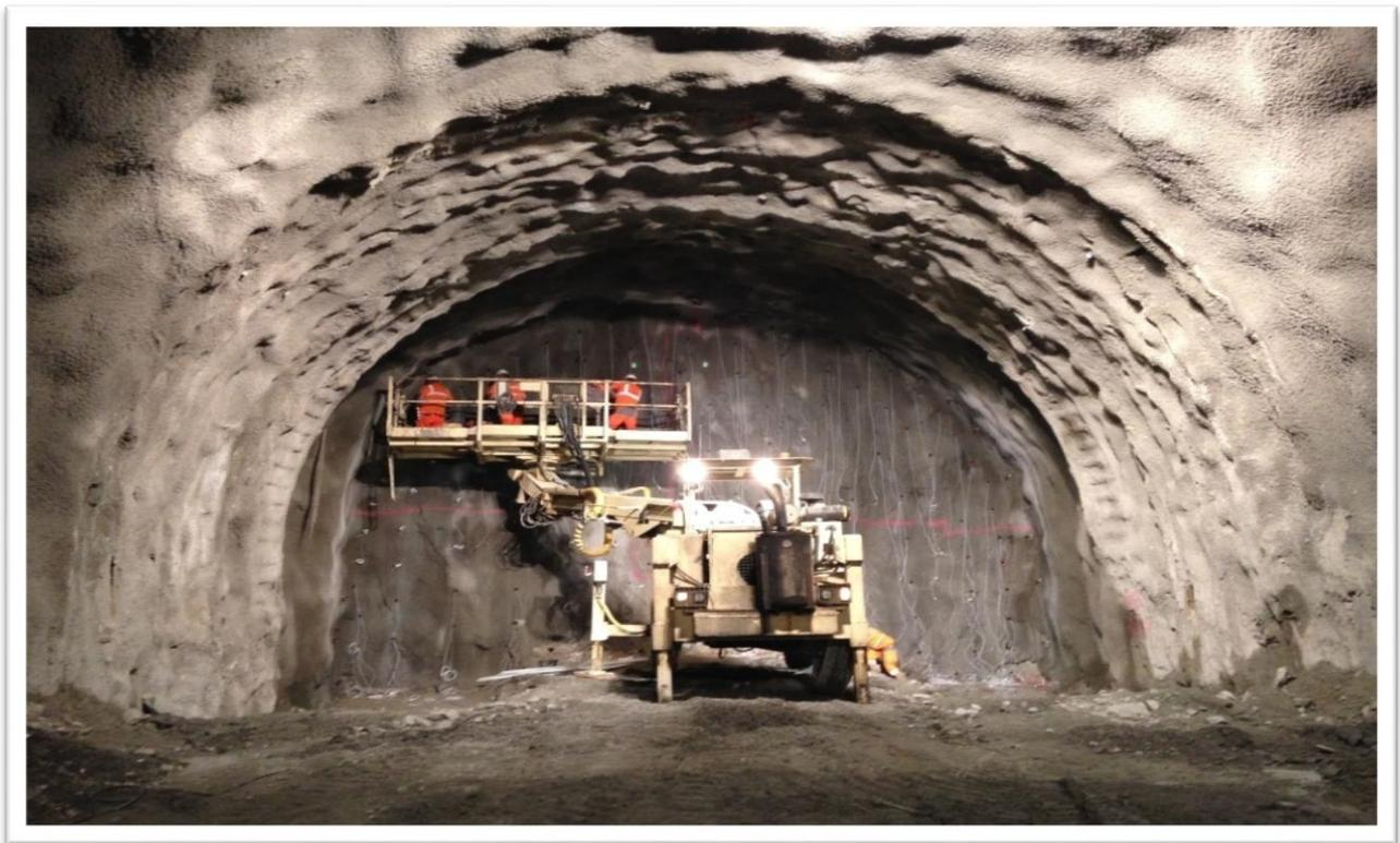
**Fig. II.9.** Creusement en pleine section
