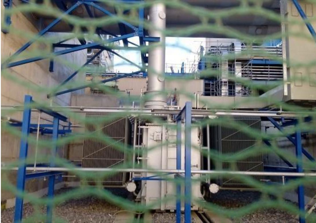
**Figure.I.17** Transformateur auxiliaire de l'unité
