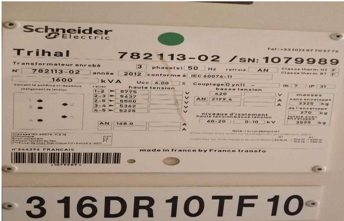
Figure (IV -4) : caractéristiques du transformateur.
