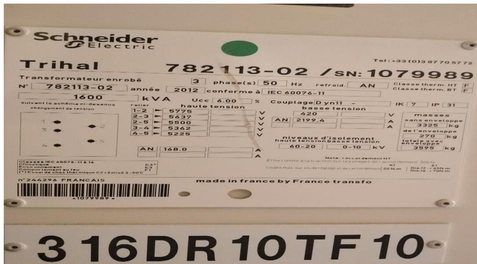
Figure (IV -21) : Plaque signalétique transformateur
