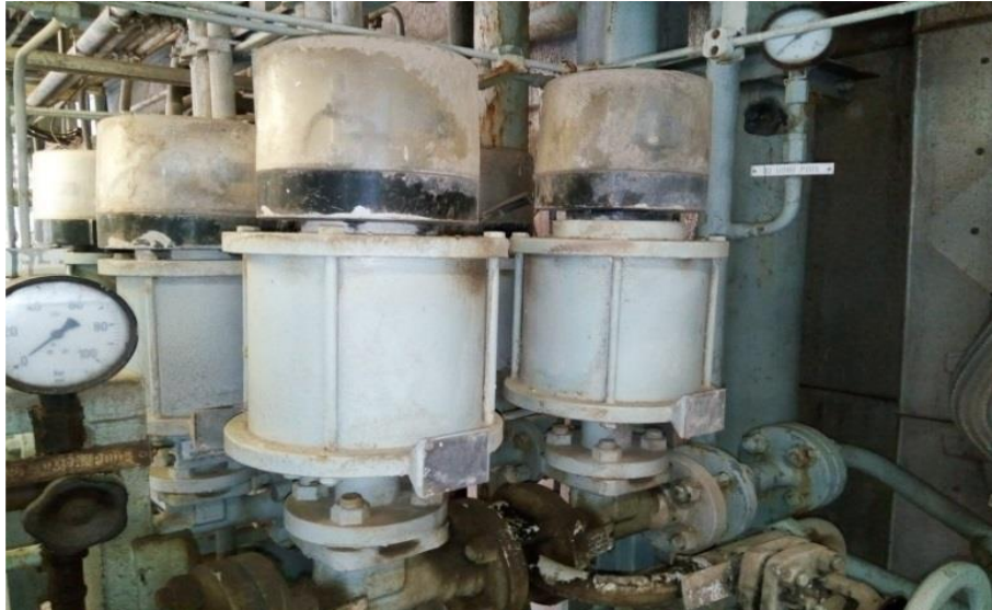
Figure 3. 11: Vannes fermeture rapides (TOR pneumatique).
