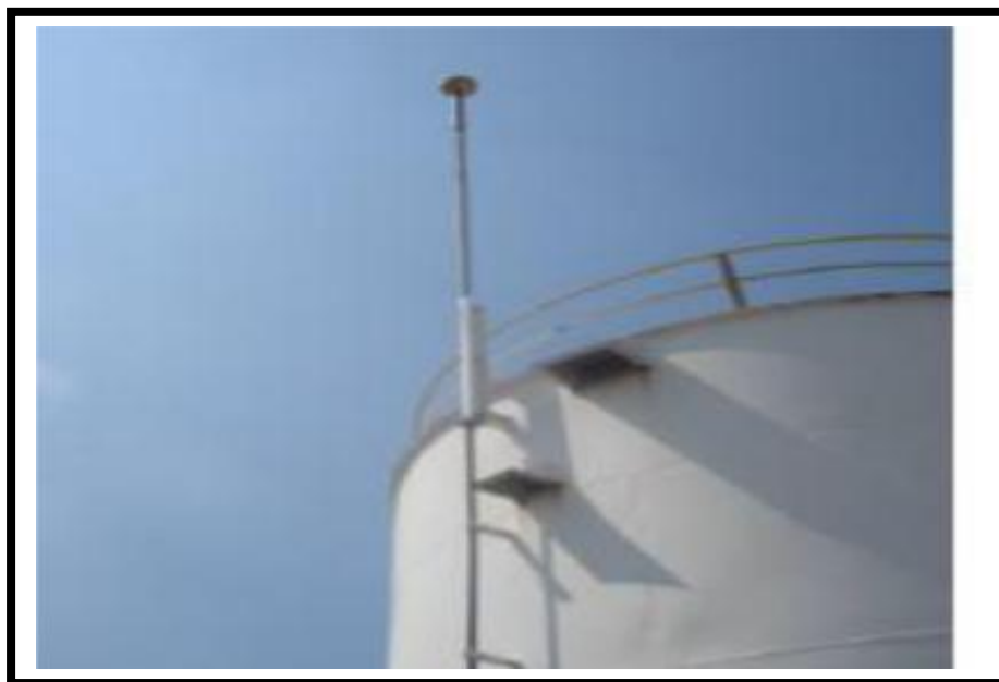
Figure VI .6 : Mise à la terre
