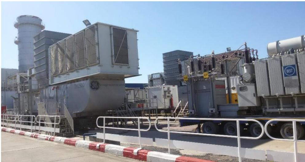
Figure I.3. Les turbines à gaz mobile TM2500 de EL HAMMA.
