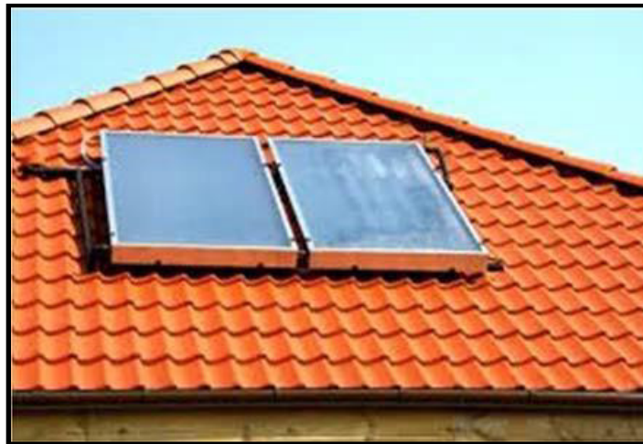
Figure 3.2: Chauffe-eau solaire à éléments séparés.
