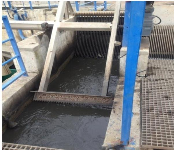
**Figure I.11** : Le dégrilleur automatique.
