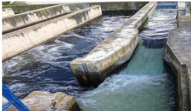
**Figure I.16** : Bassin de chloration.
