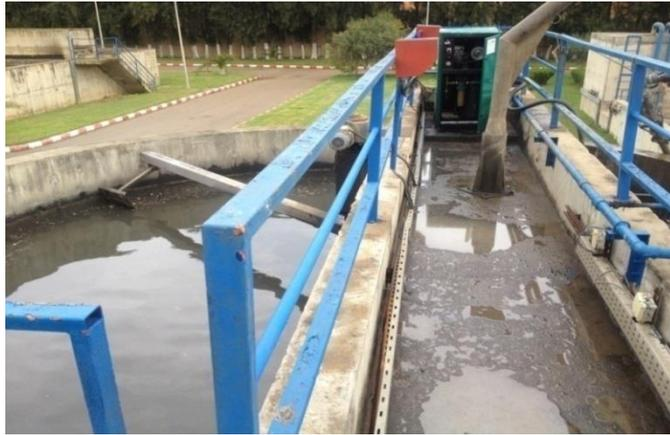
**Figure I.12 :** Dégraisseur-dessableur.
