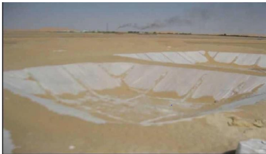
Figure I.3 : Bourbiers étanche avant le forage.
