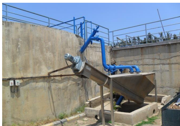
Figure N°7 : Vis à sable
