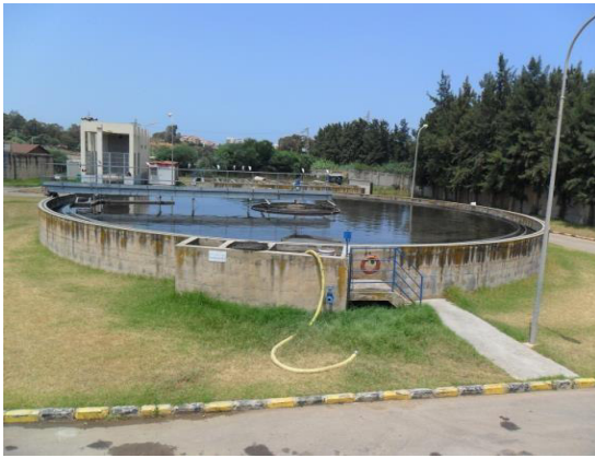
Figure N°12 : Clarificateur.
