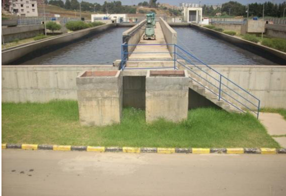
Figure N°10 :Bassin d'aération
