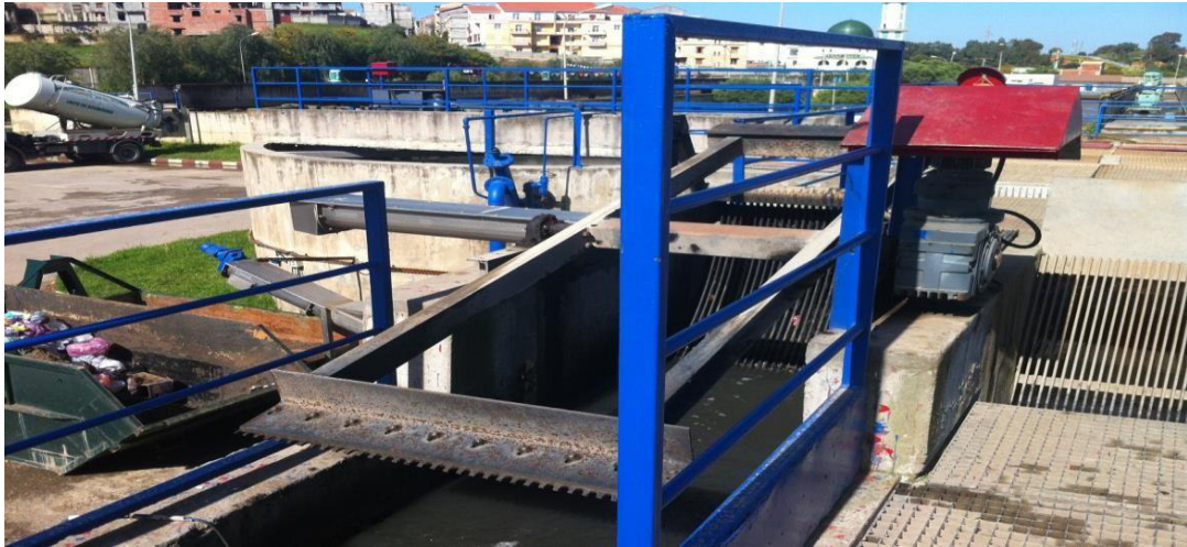
Figure N°6 : Dégrilleur.
