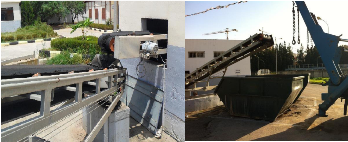
Figure N°16 : Boue déshydratée destinée à la décharge.
