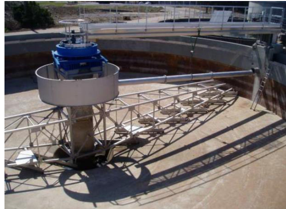
Figure N°12 : Clarificateur.
