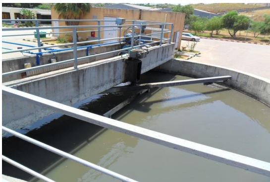
Figure N°8 : Dégraissage-déshuilage
