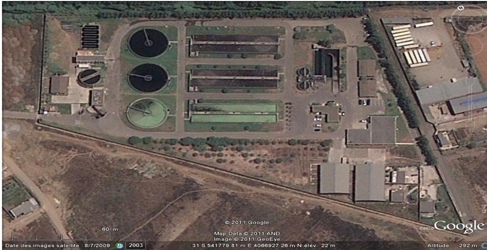
Figure N°3 : Station d'Épuration de Boumerdès vue par satellite Source : Google earth.
