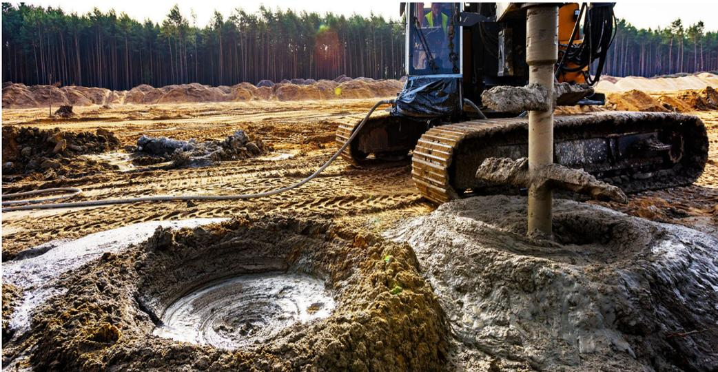
Figure V.6: Renforcement des sols par Deep Soil Mixing (DSM)-(USA 2016).
