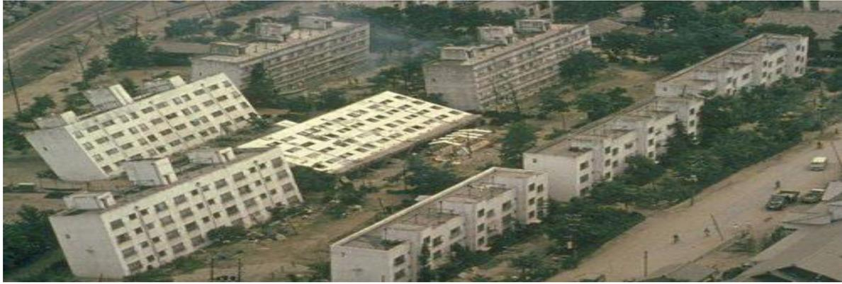
Figure I.6 : Immeubles partiellement enfouis et ayant basculé à la faveur d'une liquéfaction du sol lors du séisme de 1964 à Niigata, au Japon.
