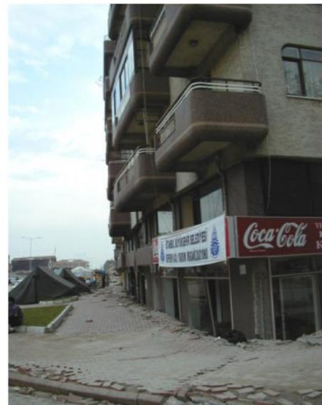
Figure I.7: Poinçonnement de la fondation sous la liquéfaction séisme Turquie 1999 (d'après Peter M. Byrne et al, 2008).
