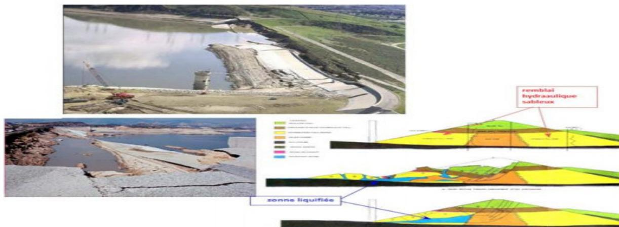
Figure I.5 : Effondrement du parement amont du barrage de San Fernando pendant Le séisme de 1971.
