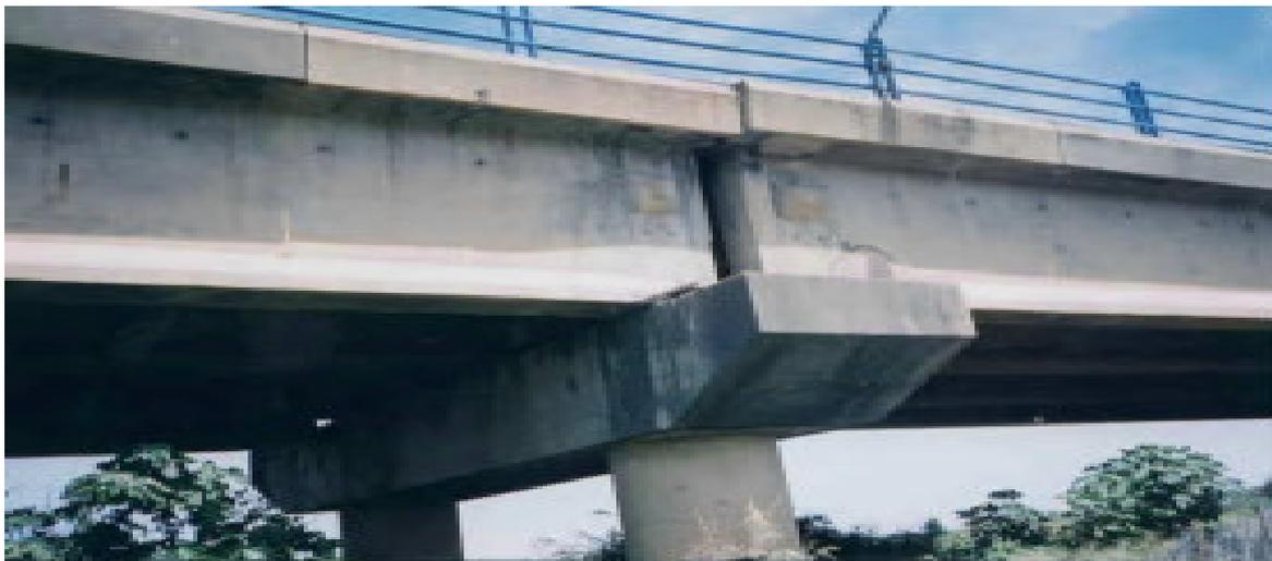
Figure I.11: Déplacement latéral et longitudinal du pont d'Isser (Boumerdes, 2003).
