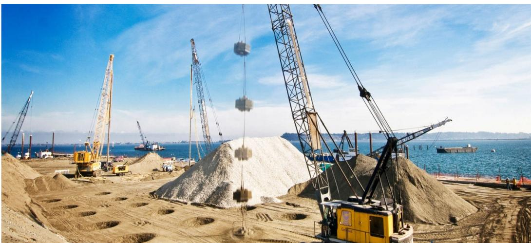
Figure V.4 : Renforcement de sol par compactage dynamique (port de Montréal).
