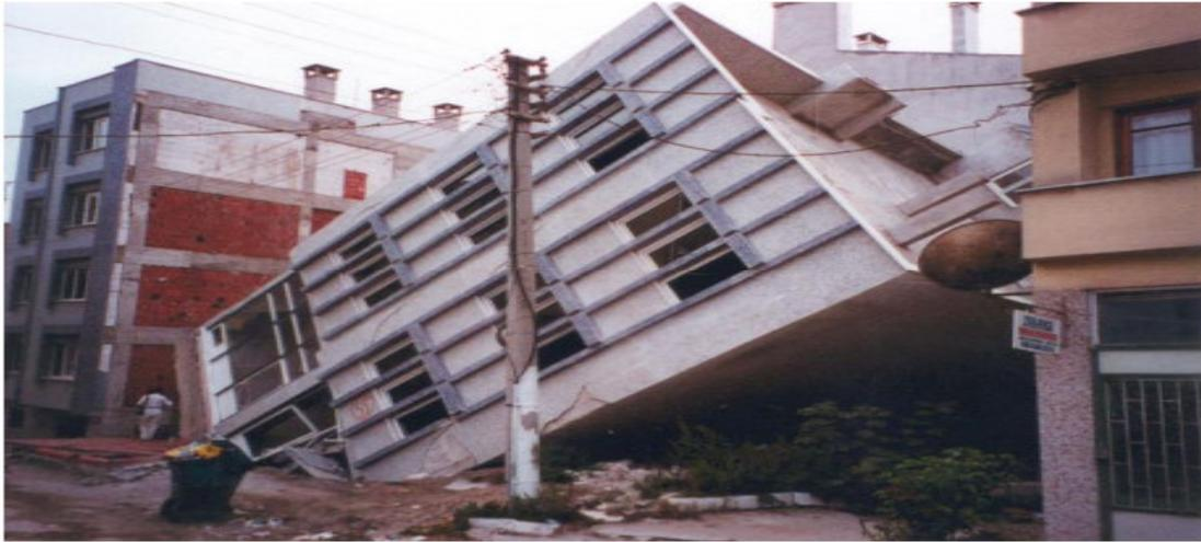
Figure I.8: renversement d'une structure sous l'effet de la liquéfaction séisme Turquie 1999 (d'après Peter M. Byrne et al, 2008).
