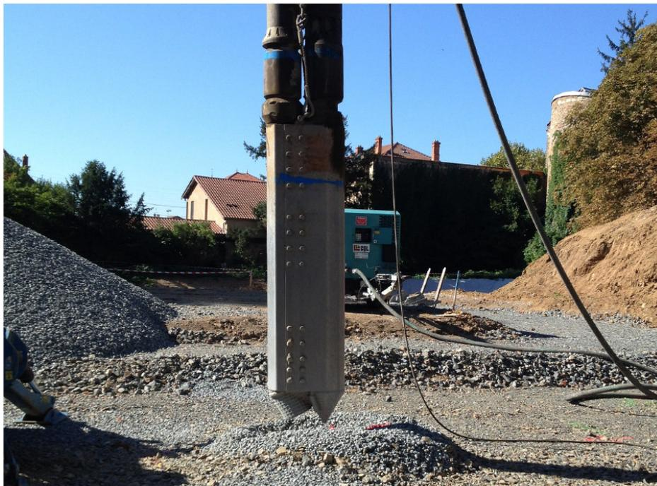
Figure V.8: Renforcement d'un sol par les colonnes ballastées (SGC Travaux Spéciaux).
