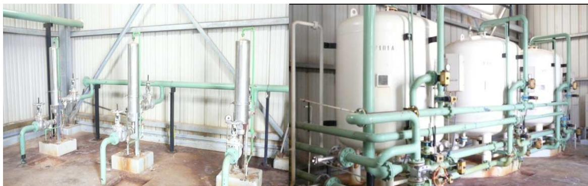
**Figure.II.7** : Photo des filtres à cartouche**Figure.II.8** : Photo des filtres à sable
