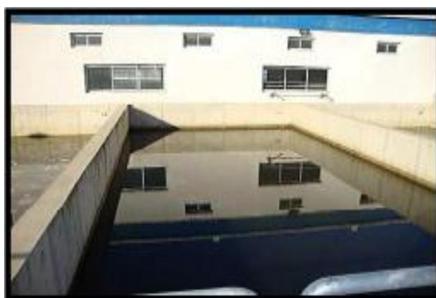
**Figure N°II.13 : Le filtre à sable.**
