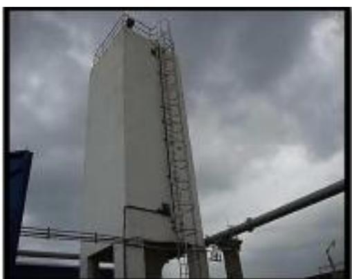
**Figure N° II.15 : Le Silo à chaux.**
