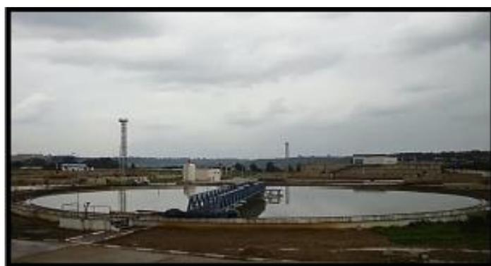
Figure N° II.10 : Le décanteur primaire.
