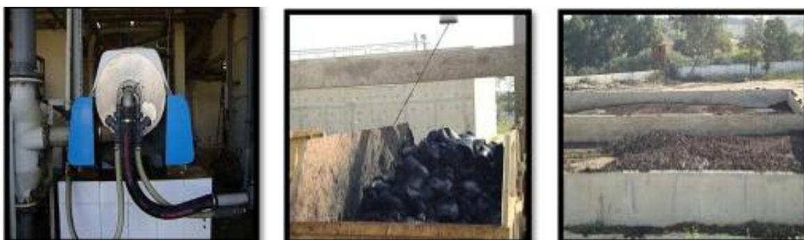
**Figure N° II.18 : La centrifugeuse, les boues déshydratée et aires de stockages.**
