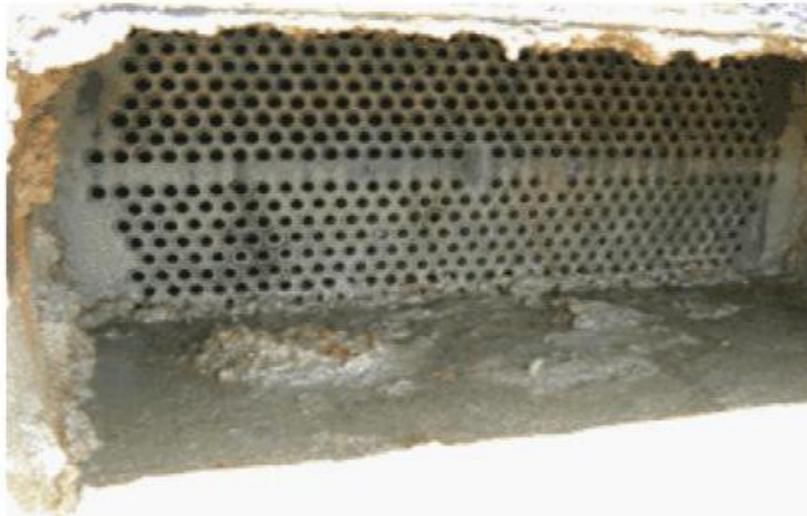
*Figure V.6 : Dépôt de slime bactérien, hydrocarbures et oxydes métallique dans un échangeur de chaleur eau hydrocarbures (Raffinerie de pétrole).*
