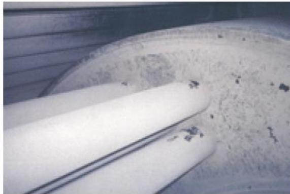
**Figure V.4 :** entartage d'une chaudière à tubes de fumée (P=15 bars)
