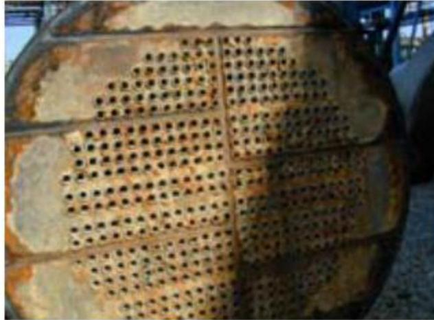
**Figure V.5 : Importante corrosion**
