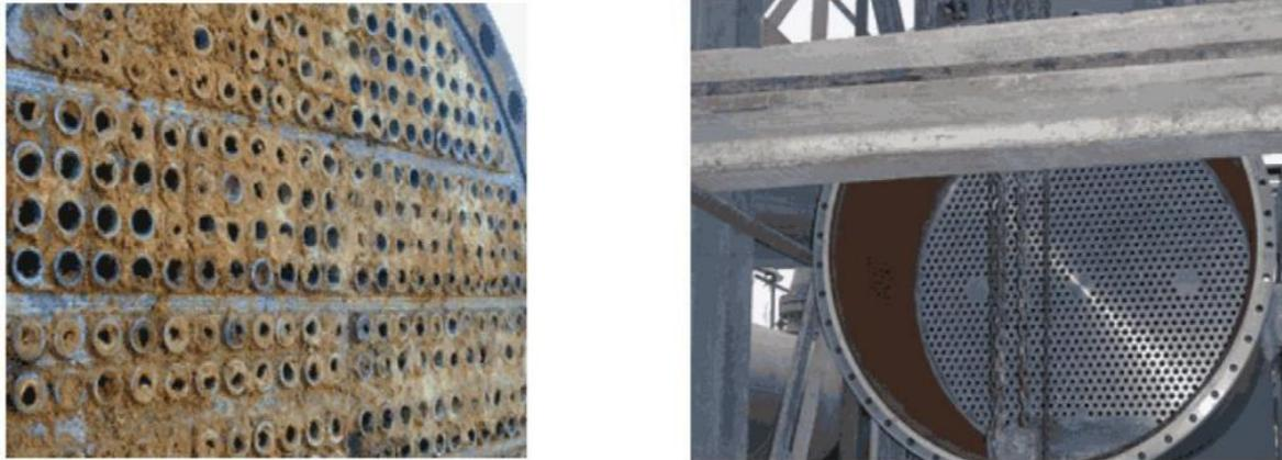
*Figure V.2 : Echangeur sale et propre*
