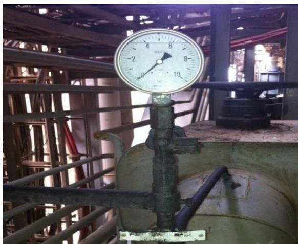
**Figure II.10** : Un manomètre.
