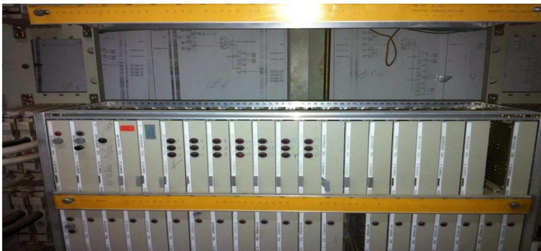
Figure II.6 : L'armoire de regroupement des classeurs.
