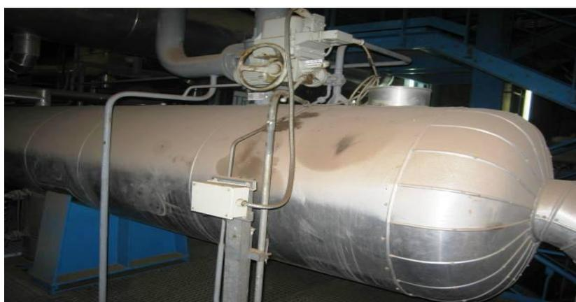
Figure I.8 : Vue d'un réchauffeur basse pression (BP).
