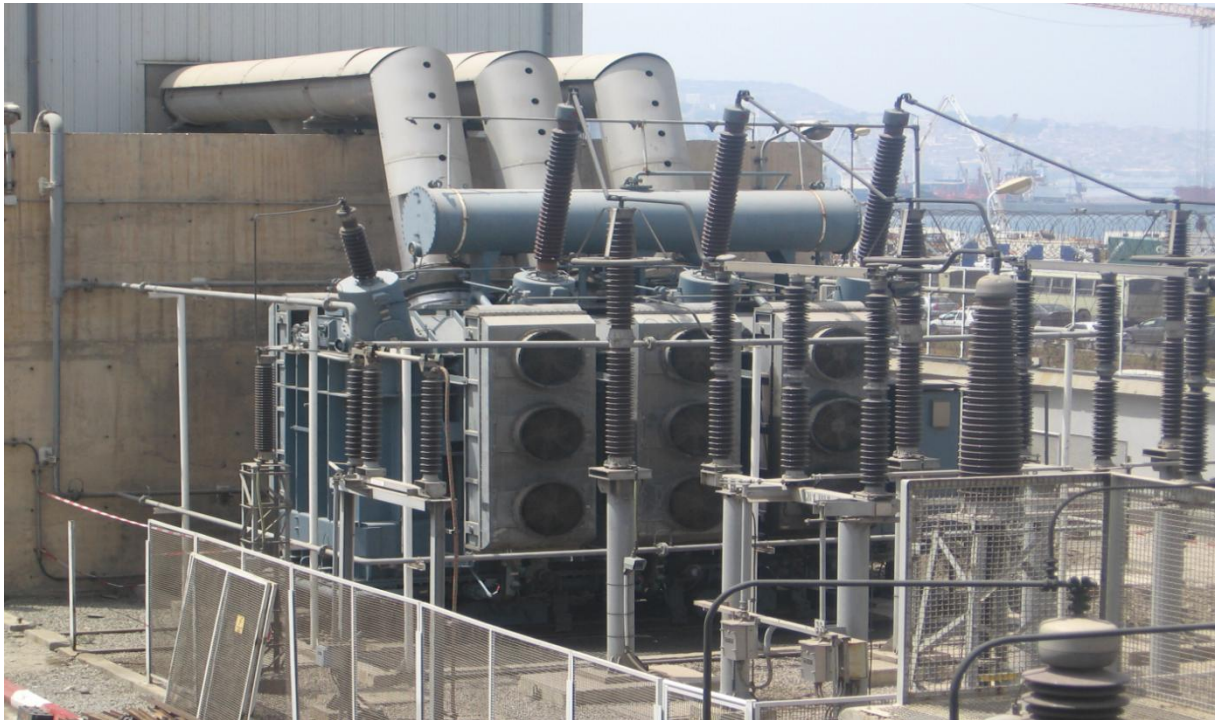
Figure I.9 Transformateur principal.
