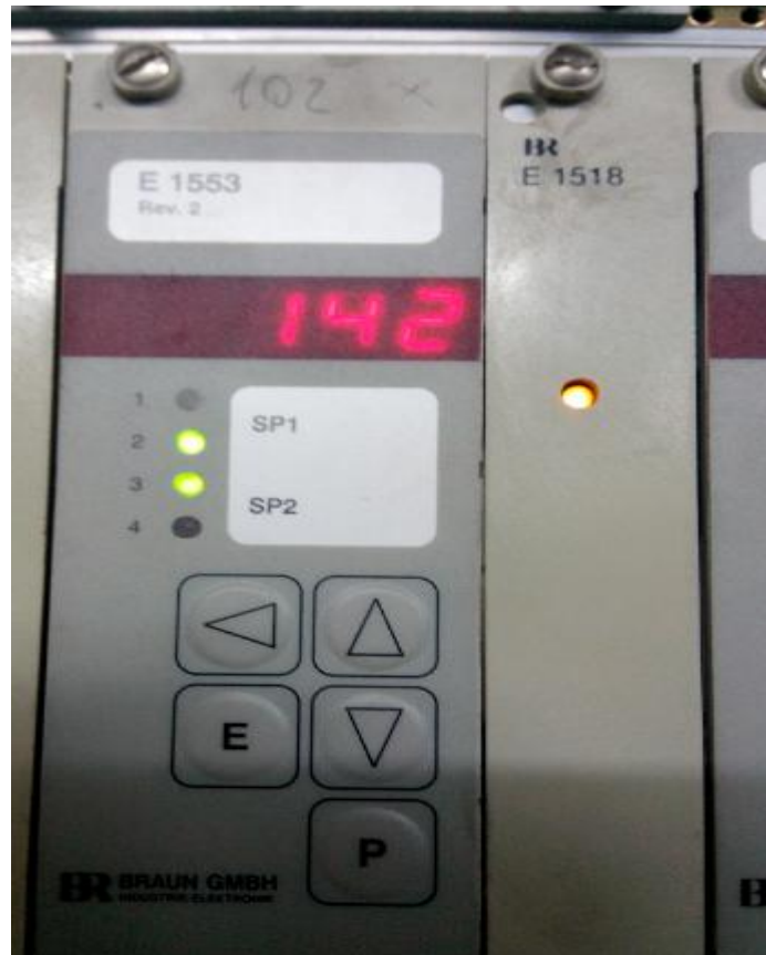
Figure III.3 Relai de vitesse E1553 et la carte d'acquisition E1518.
