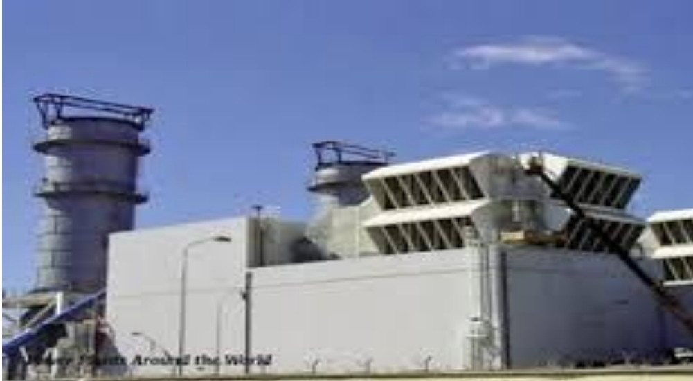
Figure I.7 Système d'aspiration d'air.
