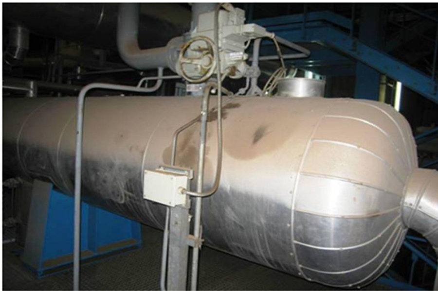
Figure I.5 : Vue de réchauffeur basse pression (BP).
