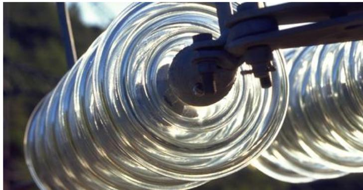
**Photo IV.1** isolateur de haute tension de type 175 CTV
