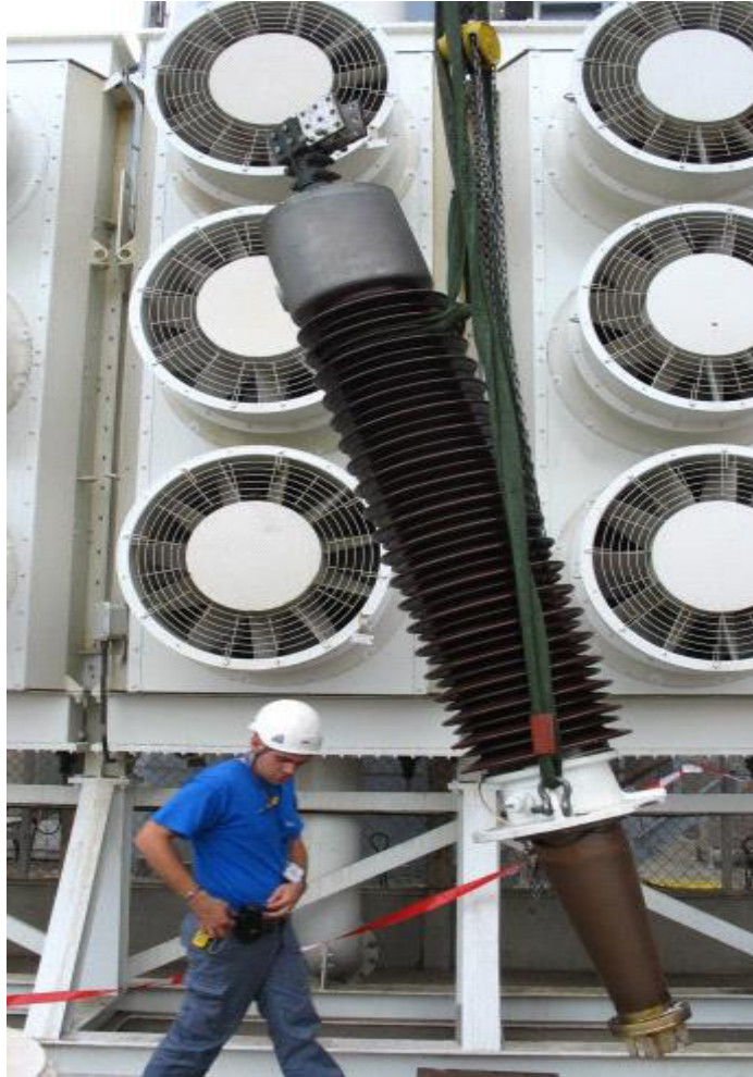
Figure (II-9) : Remplacement d'une traversée
