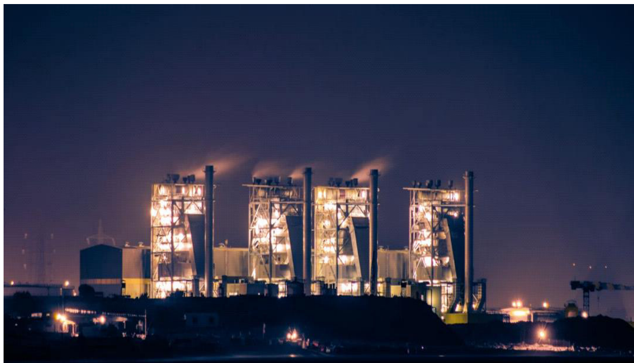
Figure (I-1) : Centrale de CAP-DJINET
