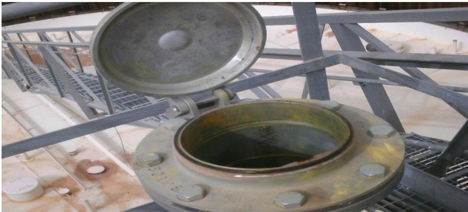
**Figure IV.18 :** Système de jaugeage
