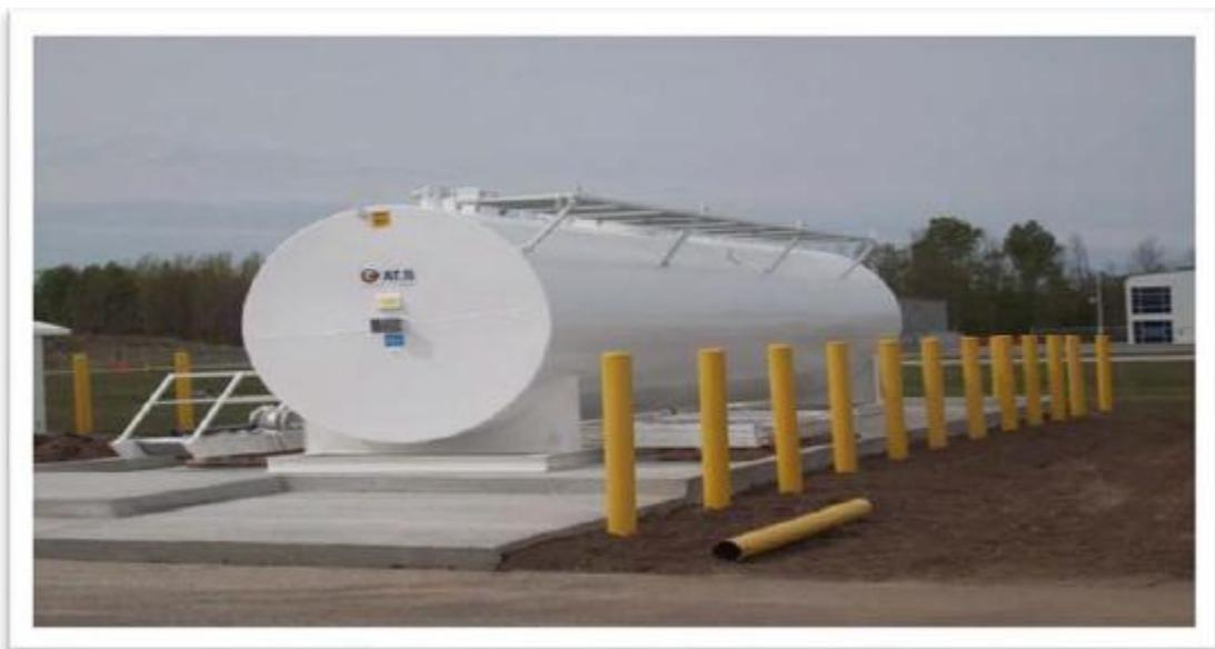
**Figure II.2** : Réservoir horizontal. [10]
