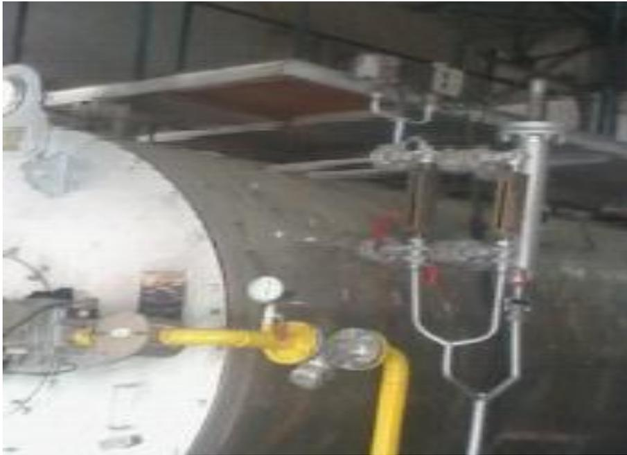
**Figure III.9 : Détecteur de niveau d'eau.**
