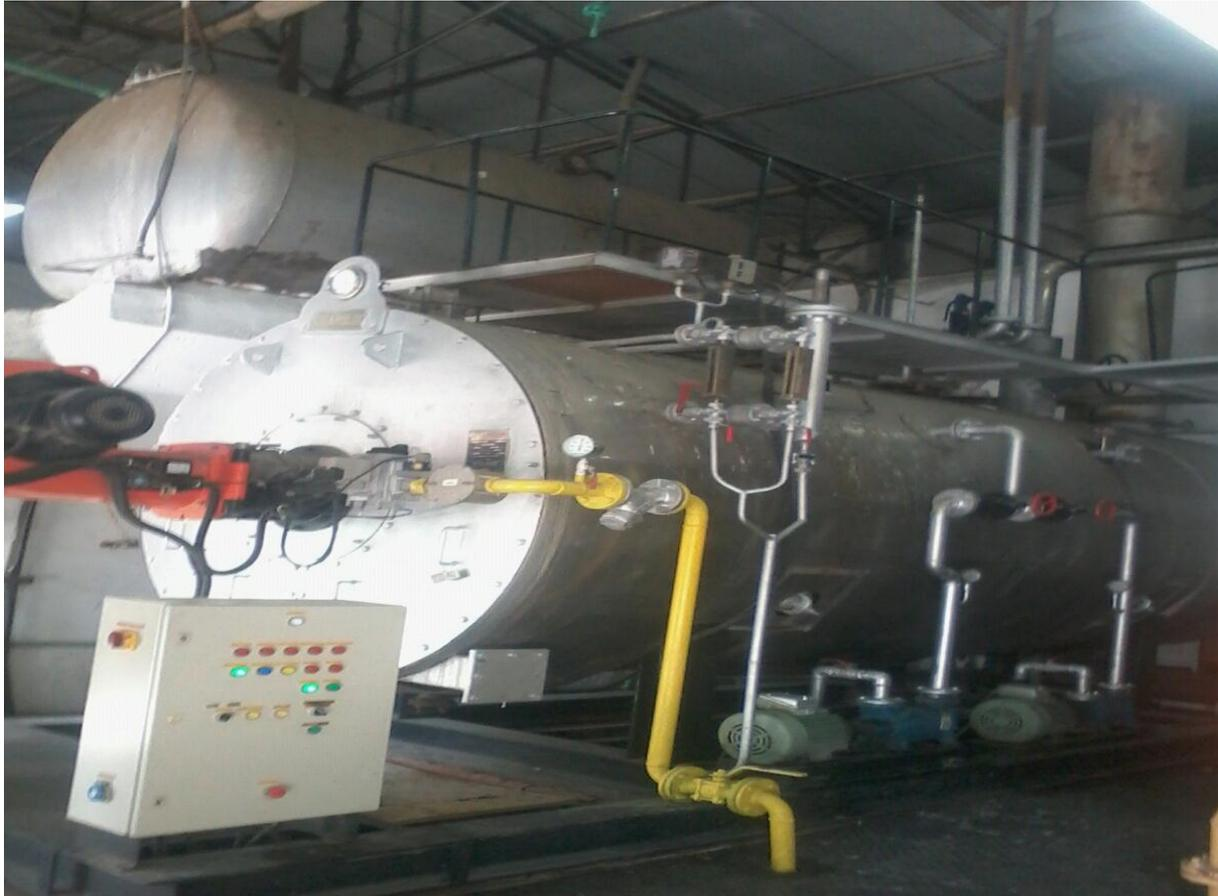
**Figure I.8 : Chaudière à vapeur de l'usine SAIDAL Dar El Beida.**
