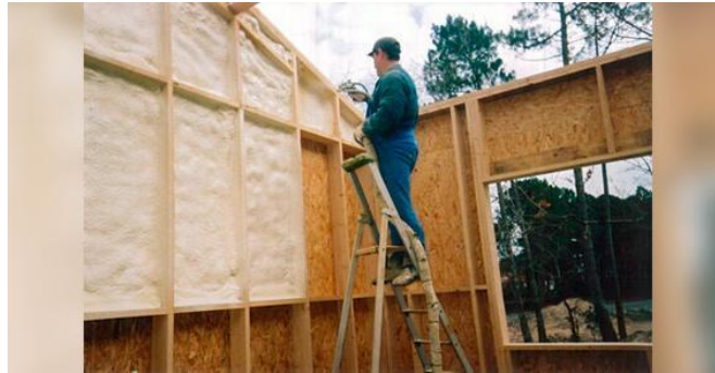
Fig.III.5. isolation des murs en verre mousse [..]
