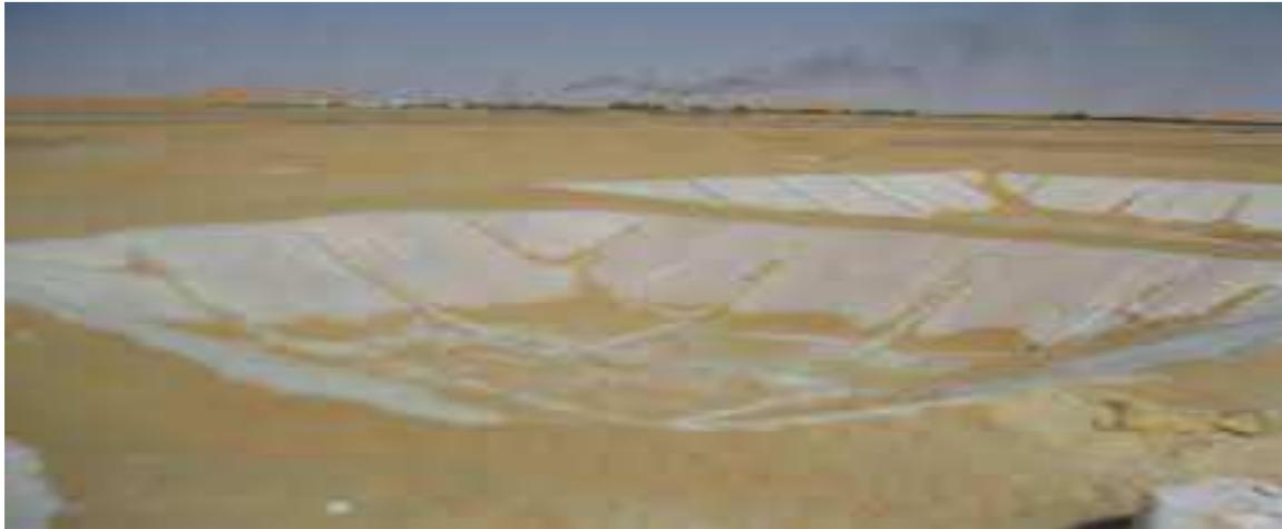
*Fig.I.12. Bourbiers étancheavant le forage*
