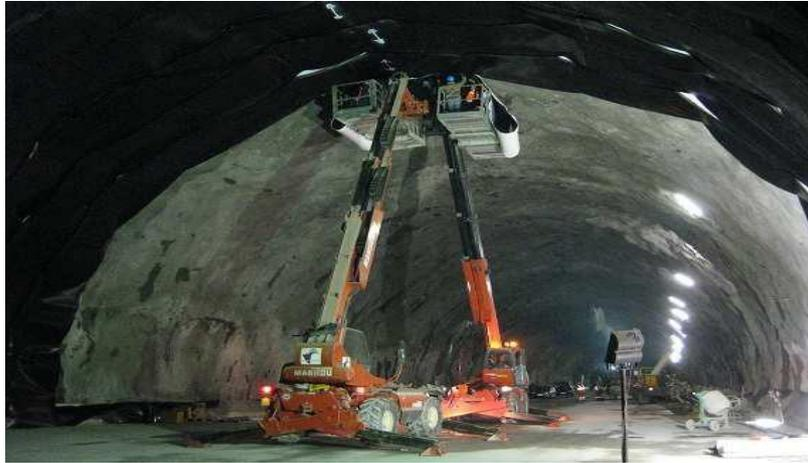
*Fig. I.4. Galerie d'un tunnel Alpin réalisé en PEHD3mm contrecollé à un géotextile pour stocker de l'amiante naturelle trouvée en excavant*
