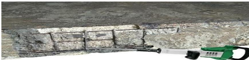
**Figure IV-2** : réparation importante sur la section d'une colonne dans un milieu agressif
