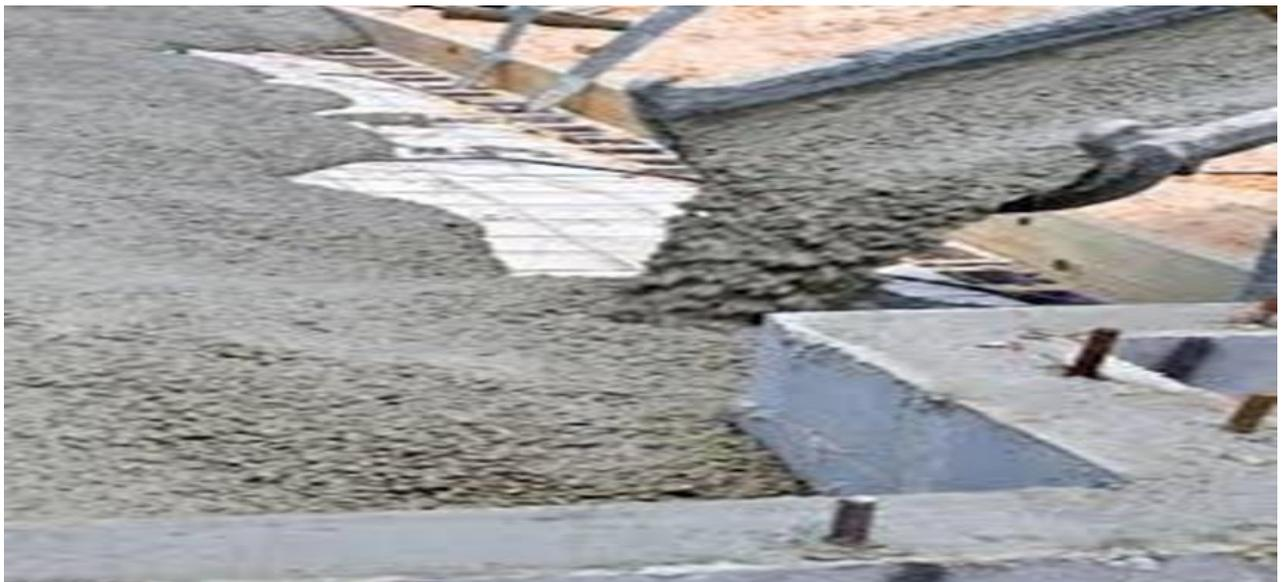
**Figure I-1** : béton autoplaçant
