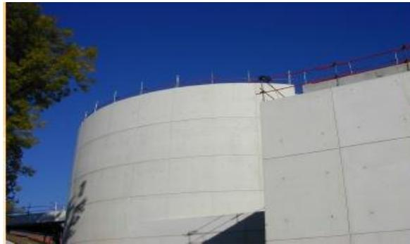
**Figure II.1: structure d'un réservoir en béton autoplaçant**
