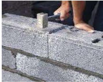
**Figure II.13.**Les joints de maçonnerie
