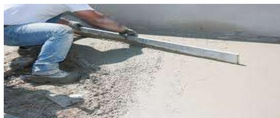
**Figure II.14.**Réglage d'une chape
