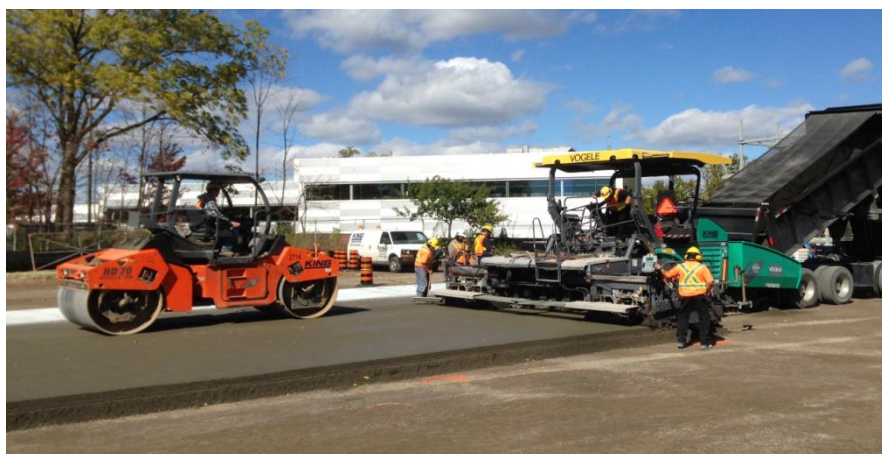
Figure.I. 4: Mise en œuvre d'un BCR.
