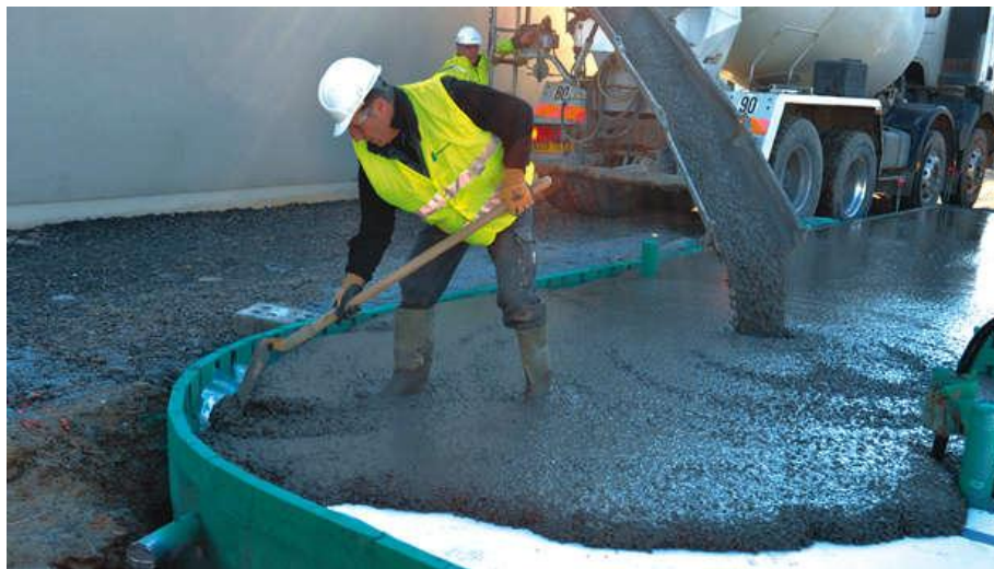
Figure.I. 3: Mise en œuvre d'un BAP.
