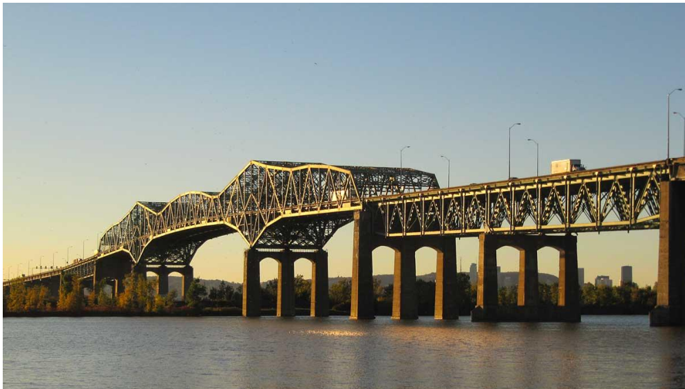
Figure.I. 1: Réfection du pont Champlain en BHP.
