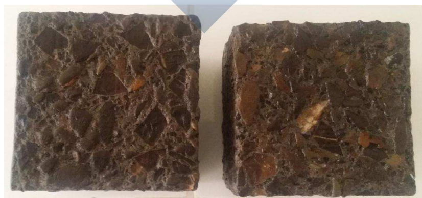
Figure (III-21) : l'état des éprouvettes du béton GF à 1, 7 et 28 jours d'immersion en milieu fortement acide
