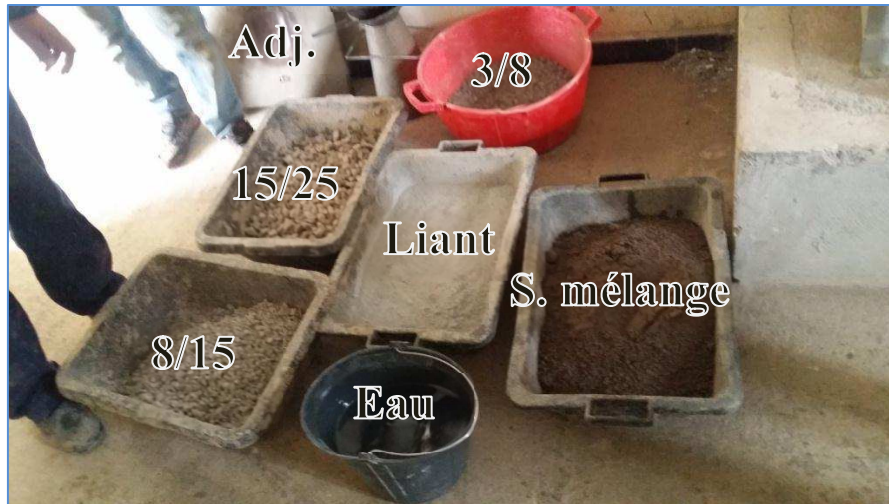
Figure (II-3) : Les différents constituants du béton BF prêts pour le malaxage.
