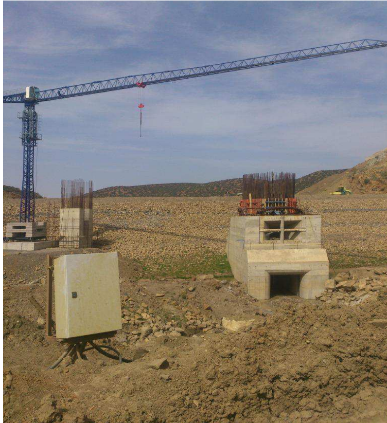
Figure (I-4) : Construction d'une tour de prise (Barrage de Béni slimane, Algérie)
