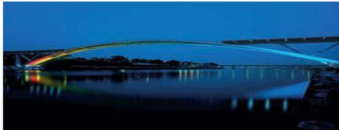
**Figure II.9 :** Passerelle de Seonyu, Séoul, Corée du sud, réalisation en Ductal® (Architecte : Ricciotti Rudy –Photographe : Rouault Philippe – Source : Médiathèque Lafarge).
