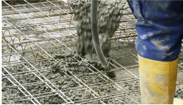
**Figure.I.4 : Béton armé**
