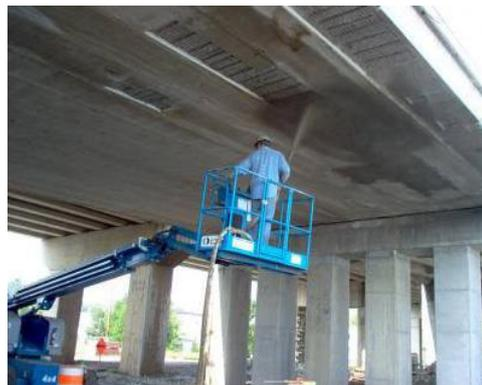
**Figure.I.7** : Réparation d'un pont grâce à l'utilisation du béton projeté
