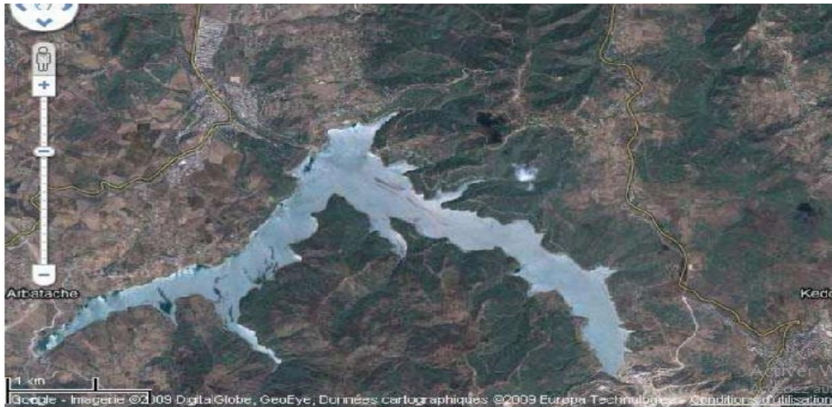
Figure III.7.2 : Photos satellite de la cuvette du barrage Keddara.
