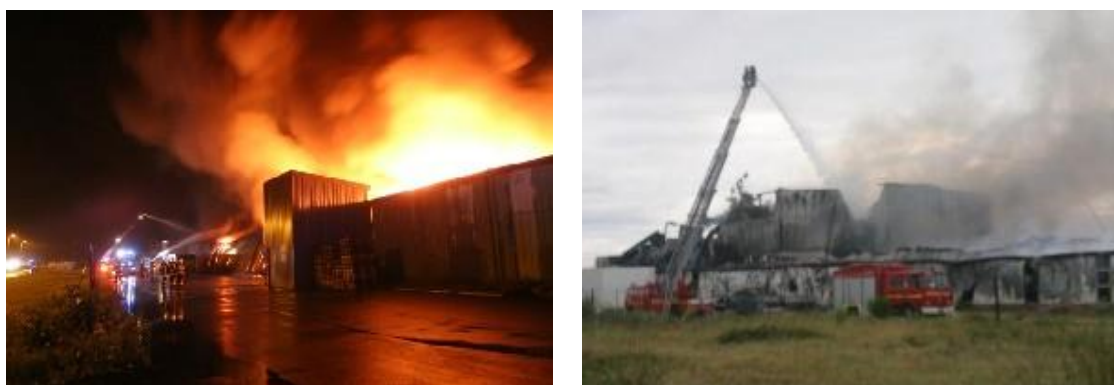
Figure 1.2 : incendie dans une usine alimentaire (accident N°2)
