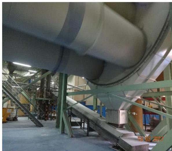
Figure 15 : sécheur refroidisseur multitubulaire
