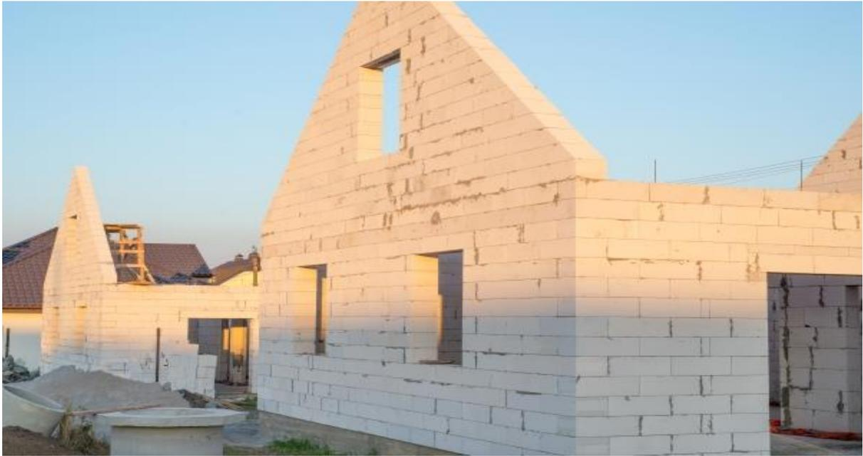
**Figure I.3 : Le béton cellulaire est parfois utilisé pour la construction d'une maison.**
