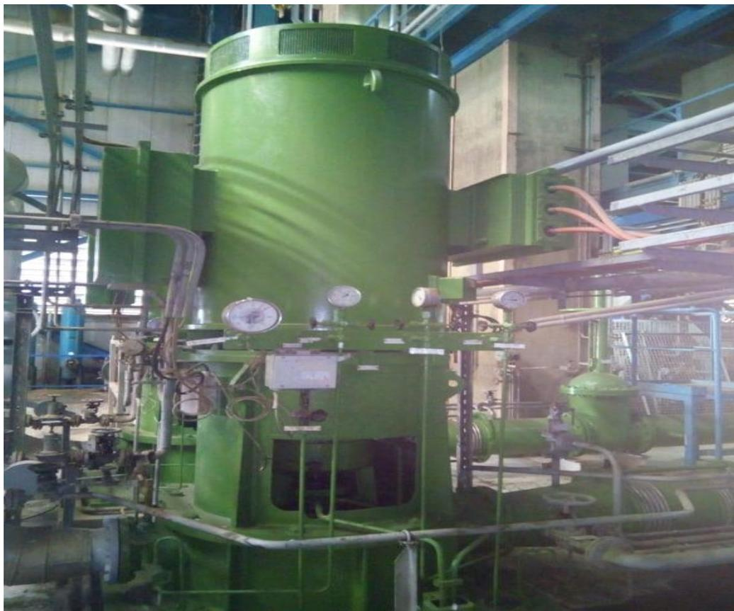
Figure 2. 13. Pompe à eau électrique
