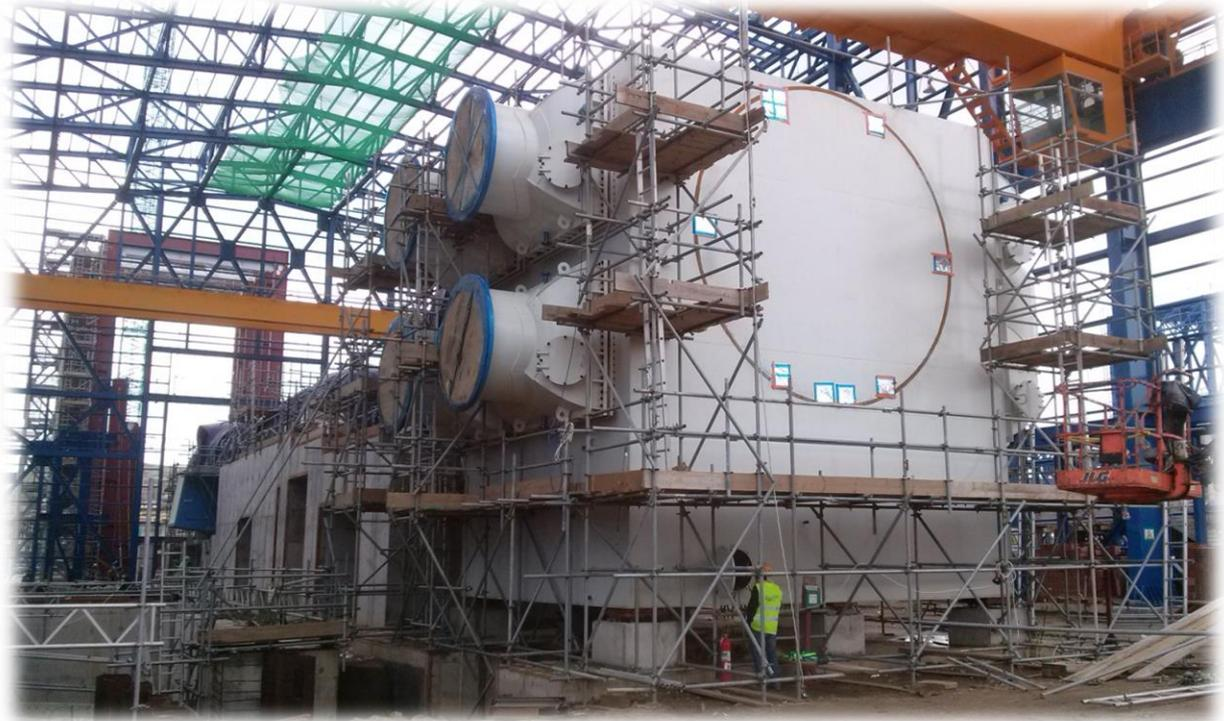
Figure 1. 14. Le condenseur à Surface avec Éjecteur d'air à jet de vapeur
