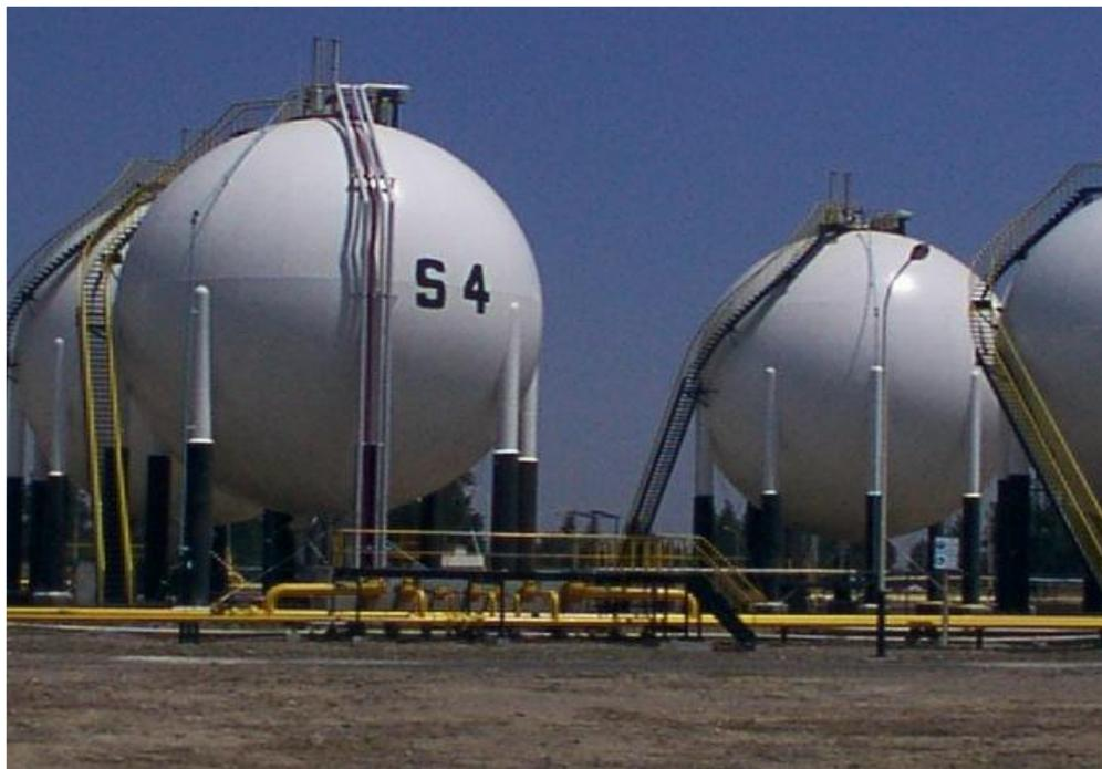
**Figure I.3:** Sphère de stockage des GAZ Raffinerie Liquide « propane et butane »
