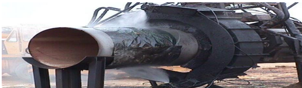
Figure III. 1 Revêtement d'un tube.
